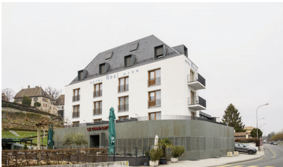
Le propriétaire de l'Hôtel Real, à Rive, sollicite un permis de démolir partiellement les volets troués qui habillent son rez-de-chaussée et entravent la vue sur le lac depuis le restaurant. CÉDRIC SANDOZ
